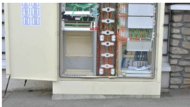
Porte PM se détachant après de trop nombreuses manipulations
