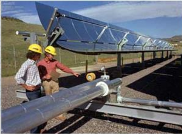
Cylindro-parabolique (200-400°C)
