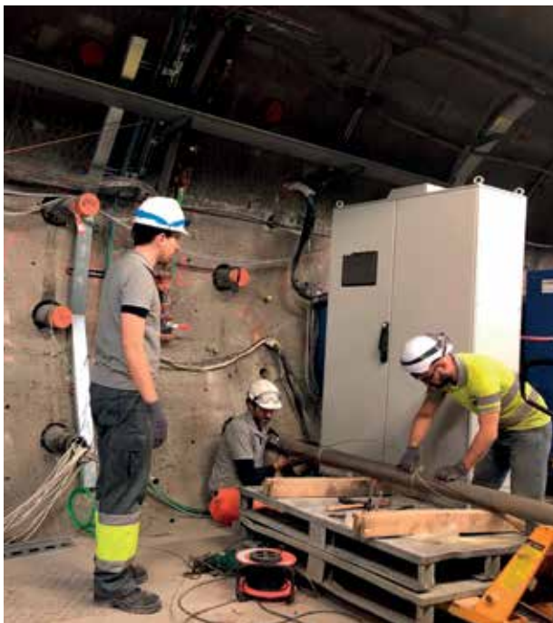
Photographie de l'installation des sondes chauffantes de l'essai CRQ
