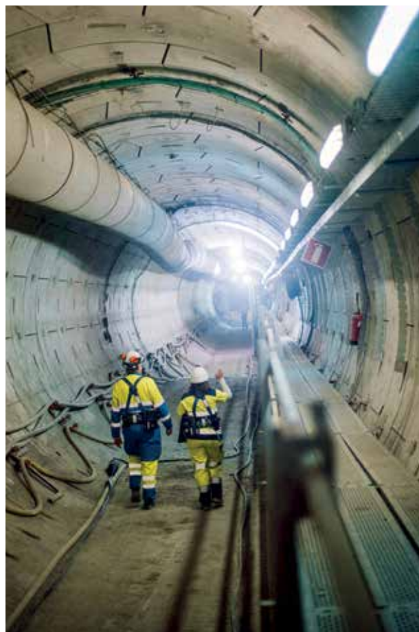
Photographie de la galerie de conception rigide (GCR) du Laboratoire souterrain de Meuse/Haute-Marne
