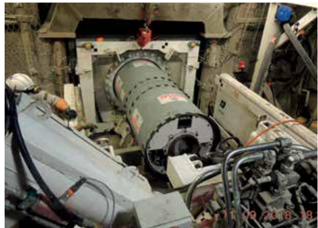
Photographie de la réalisation du démonstrateur d'alvéole HA AHA1606
