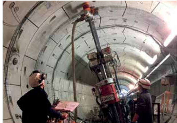
Photographie de la réalisation des forages géologiques dans la galerie GVA2
