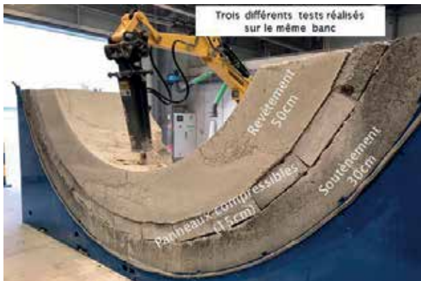
Photographie de test de mise en place de panneau compressible réalisé en surface
