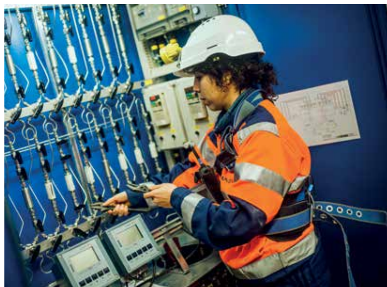
Photographie de la vérification d'une expérimentation au Laboratoire souterrain de Meuse/Haute-Marne
