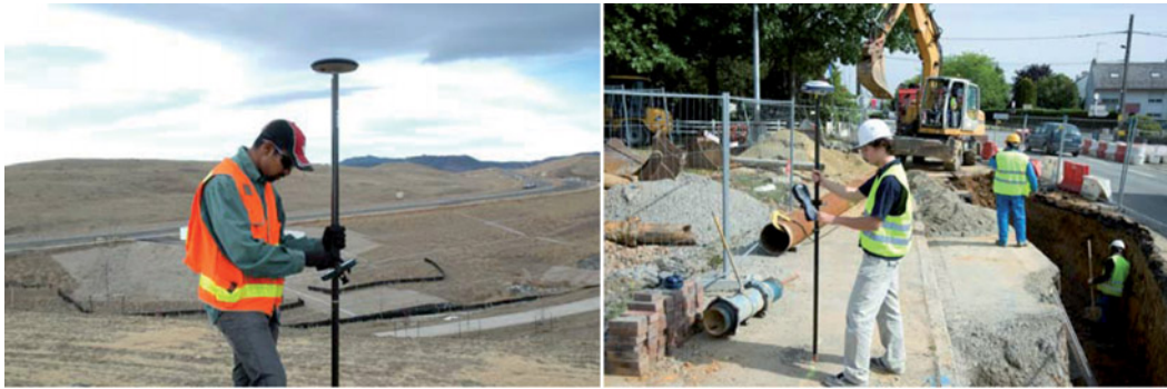
Figure 16 – Station GPS portable de « surveying » utilisée sur des chantiers de Génie civil et de construction (Crédit SpectraPrecision)
