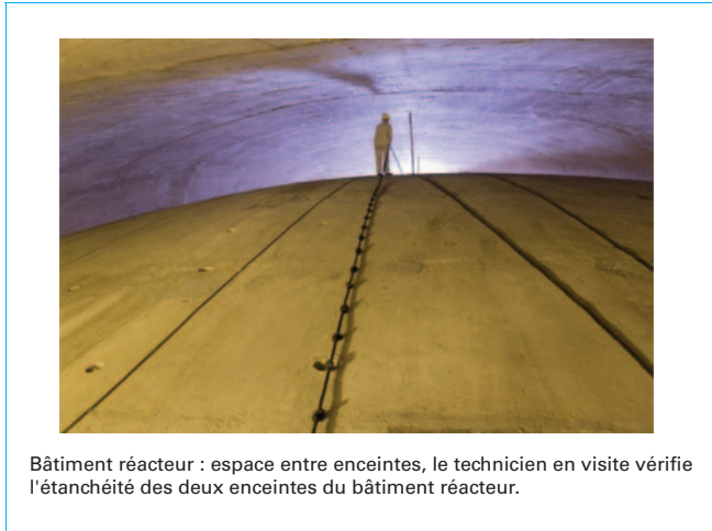
Figure 7 – Opérations de maintenance à la centrale nucléaire de Nogent-sur-Seine, arrêt de tranche 2 (©EDF)
