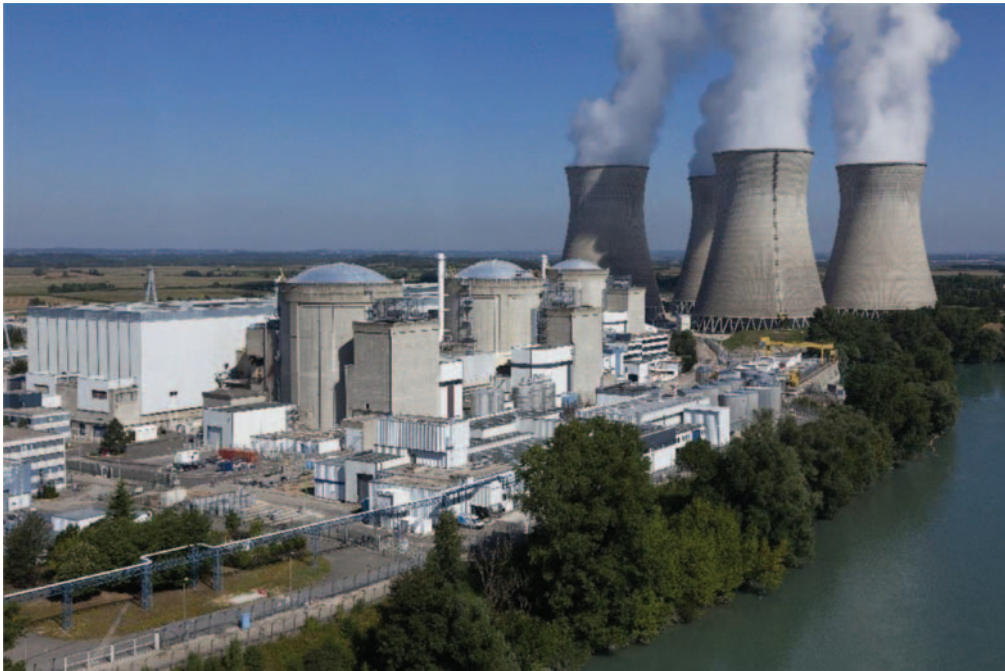
La centrale nucléaire du Bugey est équipée de quatre réacteurs de la filière des réacteurs à eau pressurisée (REP), d'une puissance de 900 MW chacun. Les enceintes simple paroi et les aéroréfrigérants sont ici visibles.
