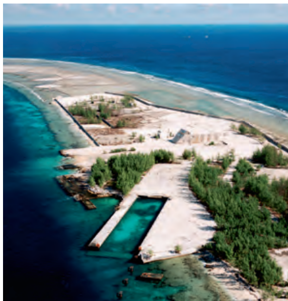
APRÈS : La zone Denise à Moruroa en 1998 après démantèlement (source : CEA/ CADAM)
