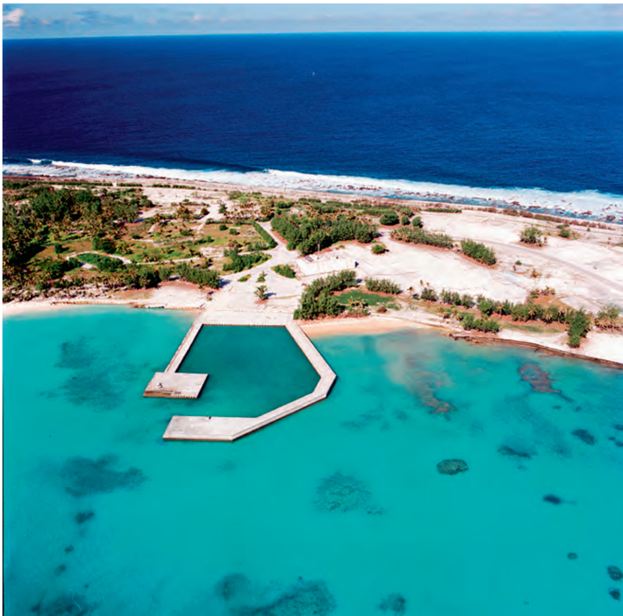
APRÈS : Zone ANEMONE à Moruroa en 1998 après le repli du CEP
