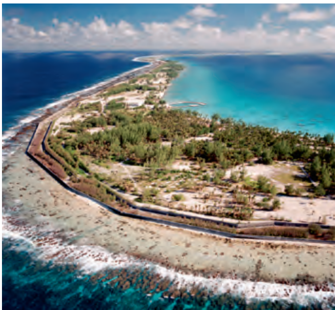
APRÈS : Le secteur Est de Moruroa en 1998 après démantèlement
